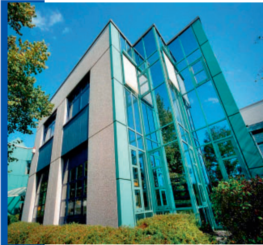
Würselen, Adenauerstraße 20/ Gebäude C
